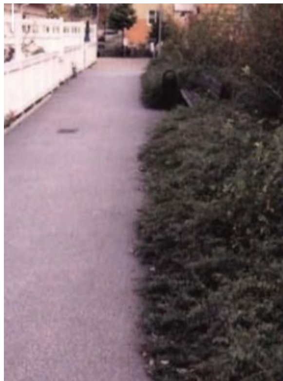
Bild 32. Exempel på en bra övergång mellan gångbana och vegetationsyta.
