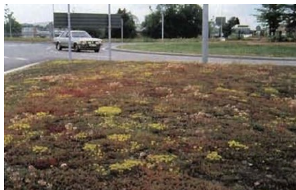
Bild 14. Refug som anlagts med torr växtbädd och sedumvegetation.
