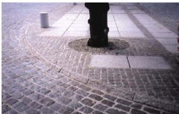
Bild 13. Stensatt yta med fog som hårdgjorts med stabiliseringsmedel i fogsanden.
