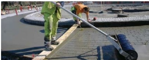
Bild 1. Platsgjuten betong i cirkulationsplats i Malmö.
