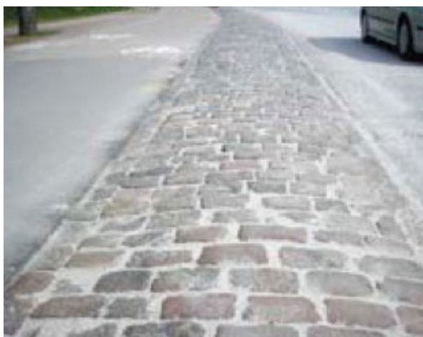
Bild 34. Ytor direkt efter försegling med betongkross och fogsand.
