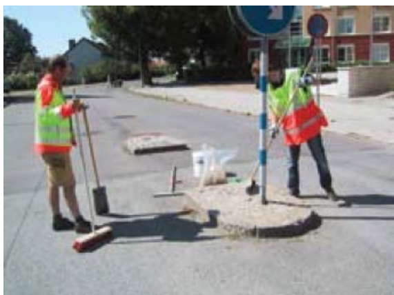
Bild 31. Utläggning av fogmaterial med olja/polymerer.
