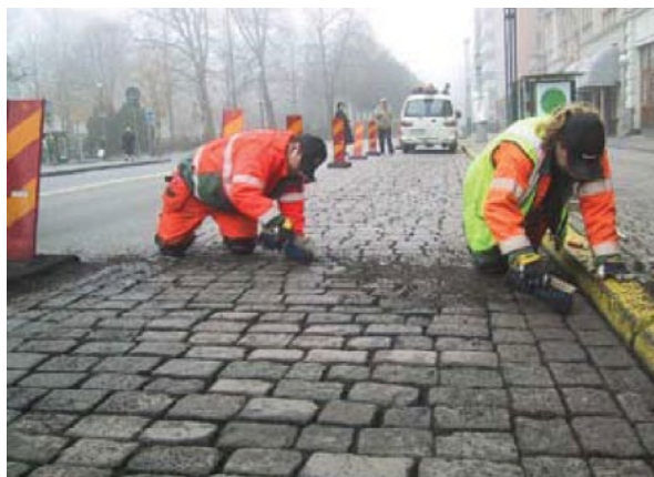
Bild 22. Rengöring av fogar.
