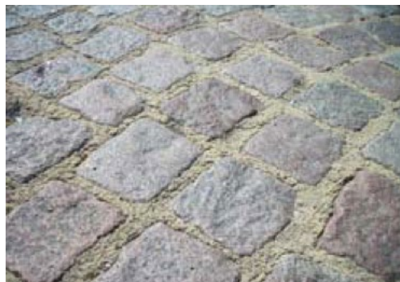
Bild 14. Epoxifogar i Gammeltorv/Nytorv, Köpenhamn.
