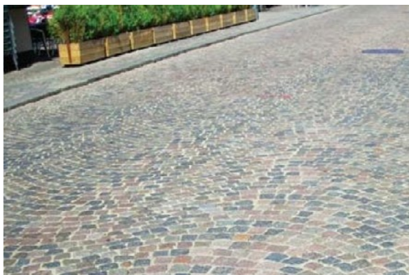
Bild 13. Epoxifogar i Gammeltorv/Nytorv, Köpenhamn.
