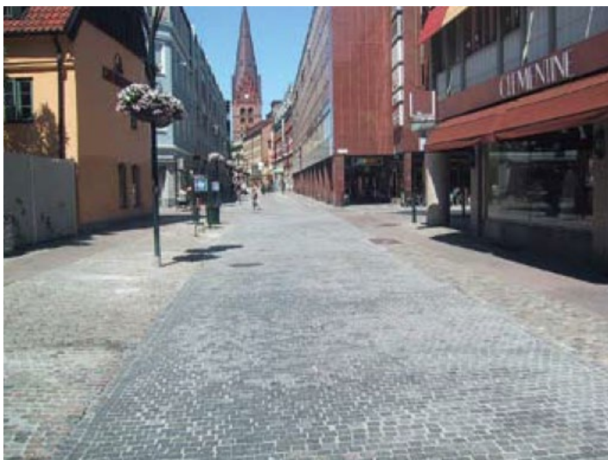
Bild 20. Kalendegatan i Malmö som är fogad med betong.
