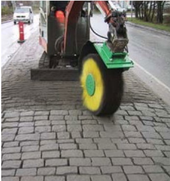
Bild 12. Test av specialborste för rengöring av fogar.
