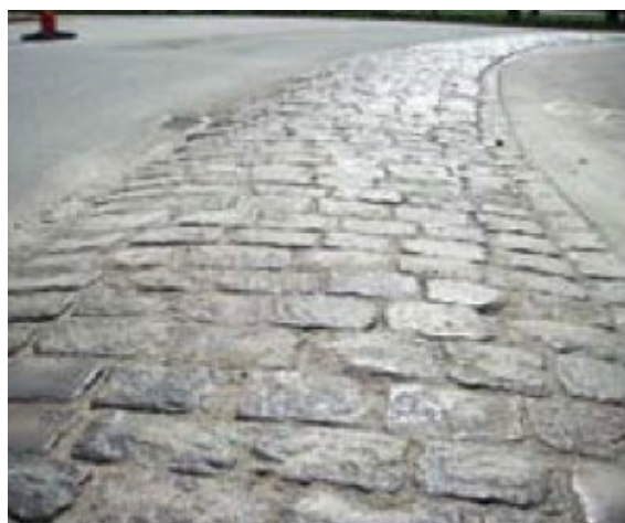
Bild 35. Ytor direkt efter försegling med betongkross och fogsand.
