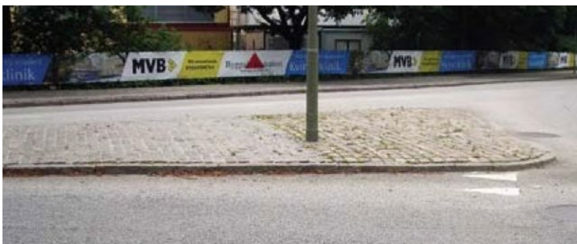
Bild 40. Skillnad i ogrästtillväxt mellan den förseglade ytan till vänster och den oförseglade ytan till höger.
