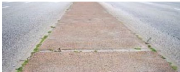
Bild 2. Platsgjuten betong på mittremsa i Malmö.
